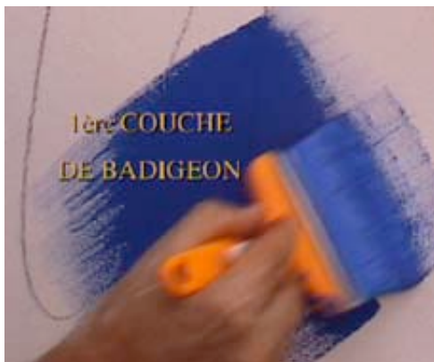
Pose de la 1ère couche
