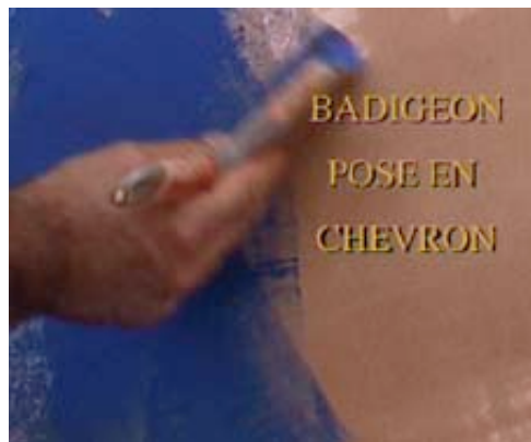
Pose en chevron de la 2ème couche.
