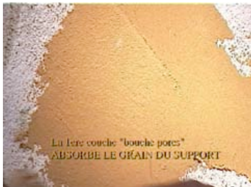
Pose de la 1ere couche. VIDÉO 2,3 Mo
