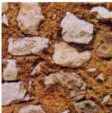
12 - Joints en terre réalisés en montant le mur.
