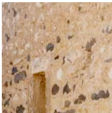
39 - Seules les grosses pierres présentant une face parallèle au mur apparaissent.
