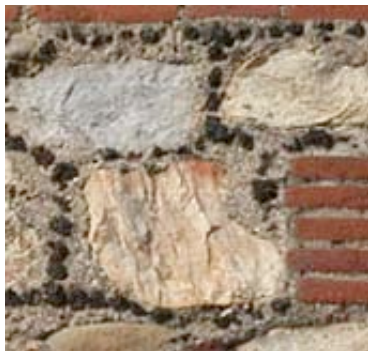
41 - Joints cloutés de tesselles noires et rouges. Grosses pierres entre lits de cayroux
