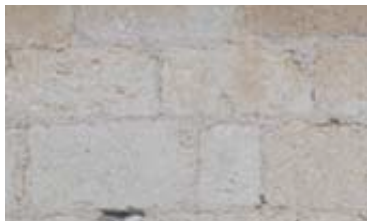
7 - Pierres équarries et joints en terre réalisés en montant le mur.
