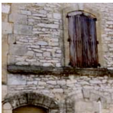
14 - Quand elle accompagne des bandeaux et encadrements en relief, la pierre de tout-venant doit-être enduite.
