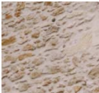
11 - Grandes et irrégulières, les joints des pierres de tout-venant s'exposent à l'eau.
