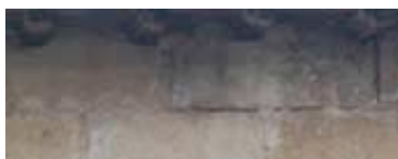
4 - Parement en pierre de taille du XVème. Joints à regarnir au nu des pierres.
