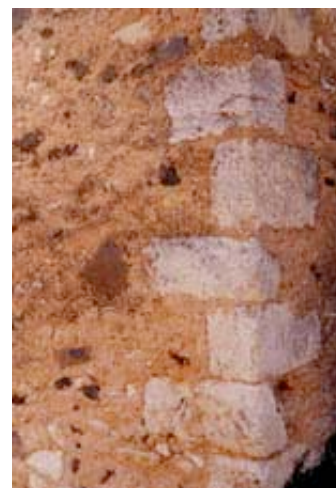
37- La chaîne d'angle harpée affleure le mortier des joints.
