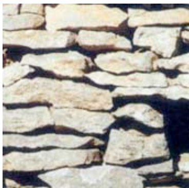
22 - Mur en pierres sèches
