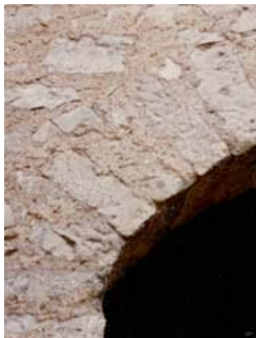
34 - Mortier de chaux et sable terreux. Joints pleins bien réalisés.
