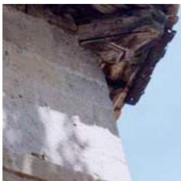
8 - Pierres équarries et joints pleins de même teinte composés de sable et de chaux.
