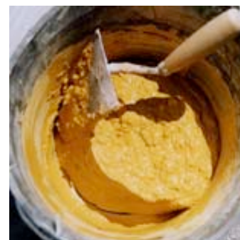
Les pigments pré dilués dans de l'eau ont été ajoutés à la pâte homogène du mortier pour stuc glacé.
